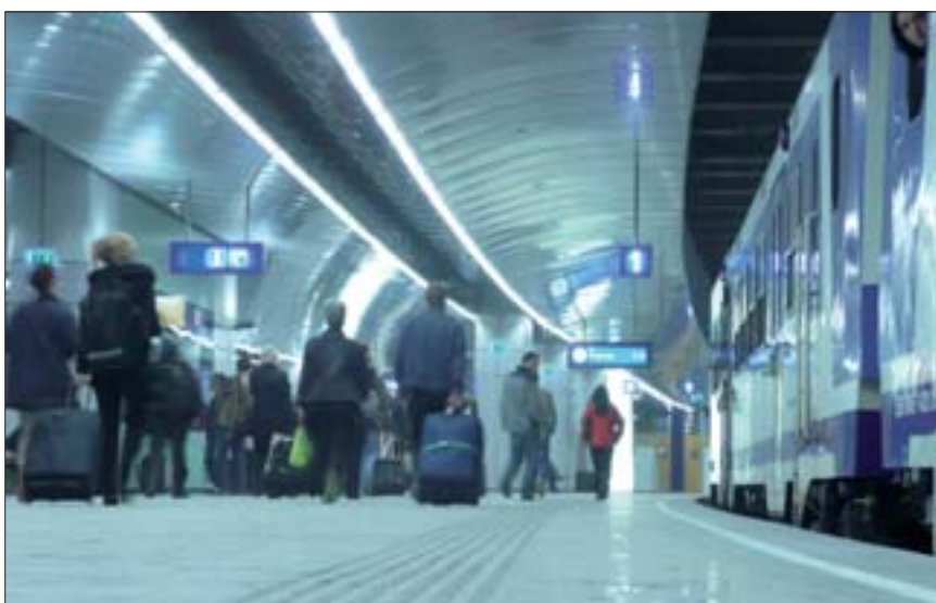
Die neuen ÖBB-Bahnsteige am Bahnhof Flughafen Wien Schwechat
