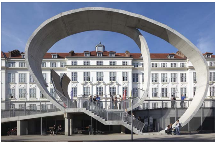
Das Hauptgebäude der Donau Universität Krems ist die modern adaptierte ehemalige Tabakfabrik Stein, ein charakteristischer Industriebau des 20. Jahrhunderts.
