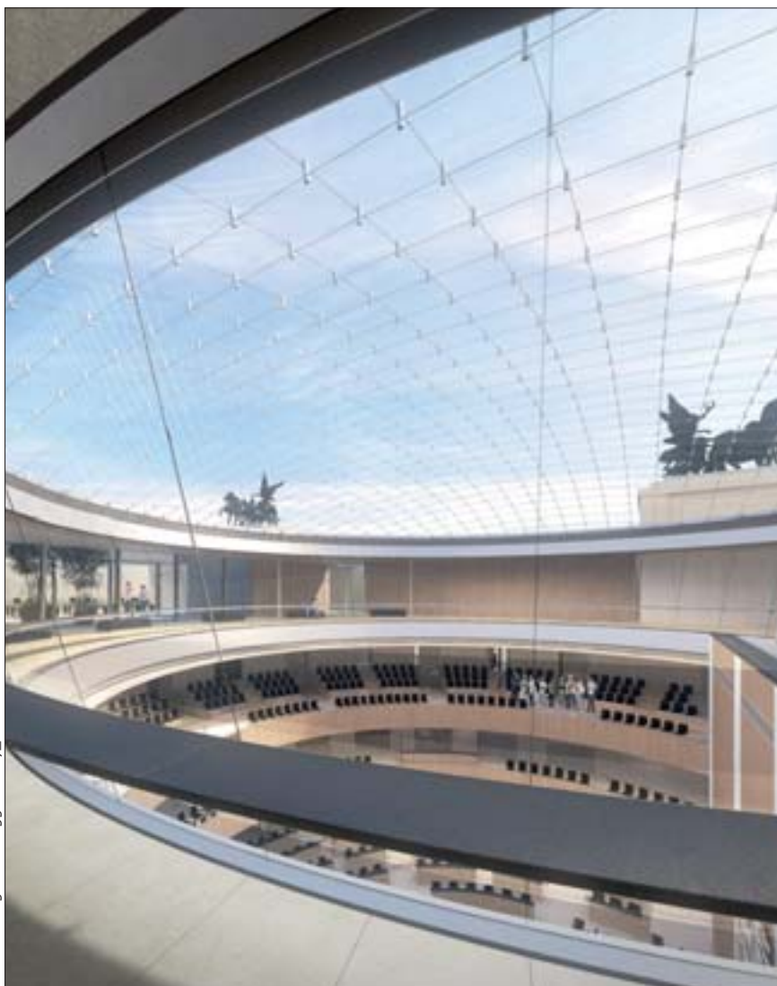
Das Dach über dem über dem Nationalratssaal besteht aus einer frei tragenden Glaskugelkalotte und einem die Kalotte unterstützenden Stahlträgerrost.
