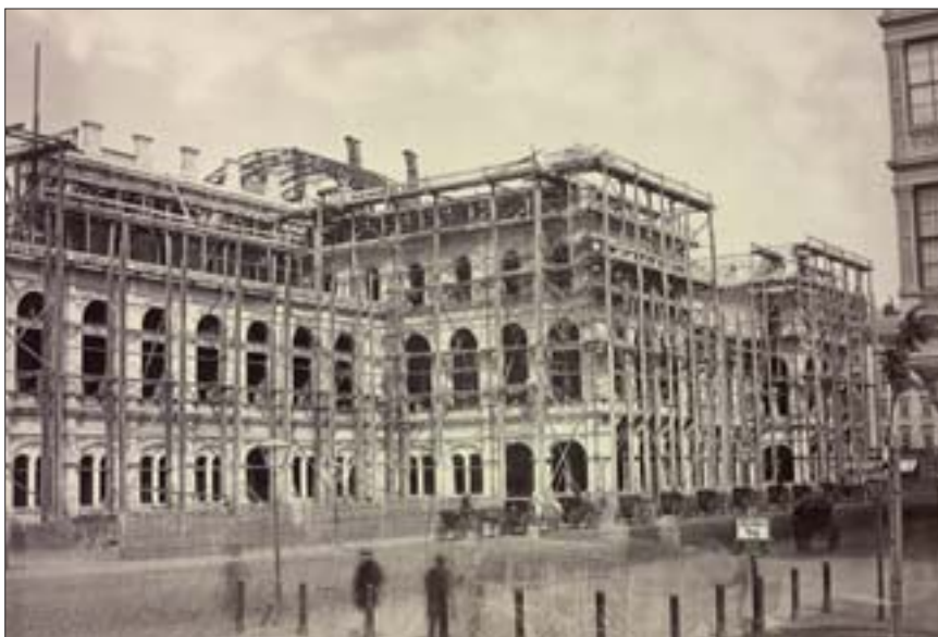
Die Oper bei Erreichen der Dachgleiche, Fotograf unbekannt, um 1865
