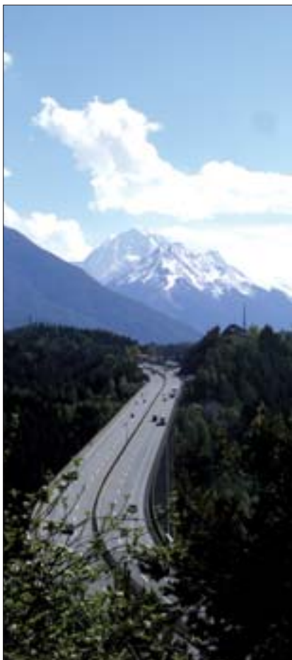
Auch die Brenner-Autobahn mit der Europabrücke bei Patsch führt die ÖsterreicherInnen seit Jahrzehnten in ihr Lieblings-Urlandsland Italien
