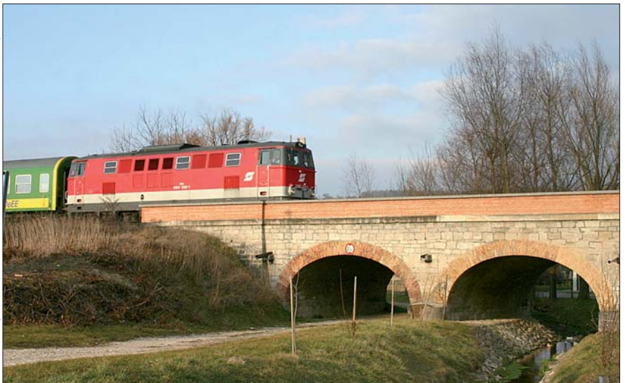
ÖBB 2143.030 auf einem Viadukt der Mattersburger Bahn
