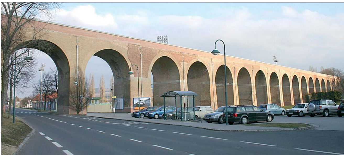
Auch das 1847 errichtete Wahrzeichen von Mattersburg, das Viadukt, benötigt eine »Generalüberholung«.
