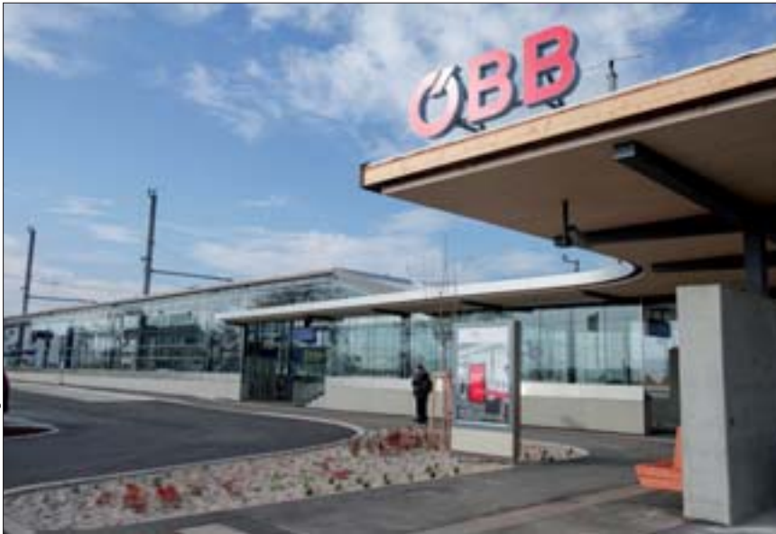
Der neue Bahnhof Neusiedl am See – modern und fahrgastfreundlich
