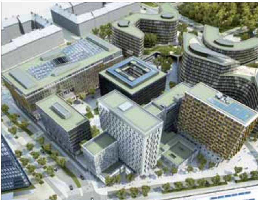
Nahe dem Hauptbahnhof entsteht mit dem »Quartier Belvedere« ein Entwicklungsprojekt, das sechs Bauteile auf rund 25.000 m 2 Grundstücksfläche umfassen und einen umfassenden Nutzungsmix beherbergen wird. Die Fertigstellung ist für Ende 2016 geplant. http://www.qbc.at
