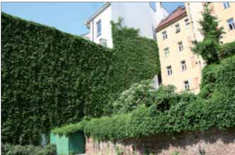
Eine durchdacht angelegte Pflanzenhülle ist überdies ein natürlicher Schutzschild gegen Schlagregen und UV-Strahlung und kann damit die Lebensdauer einer Fassade erhöhen.
