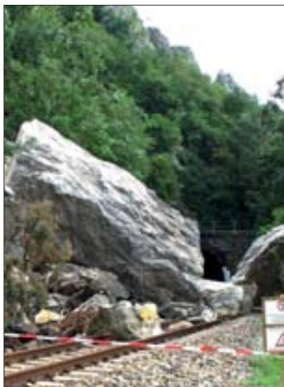
Beispiel für eine Hangrutschung
