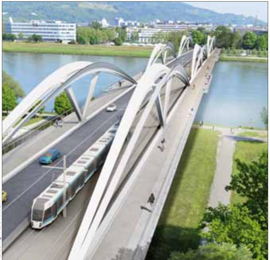
Für Bus und PKW stehen zwei Fahrspuren mit je 3,5 Meter Breite, für die Schienen sechs Meter Breite, für Fußgänger auf beiden Seiten je zwei Meter und für Radfahrer auf beiden Seiten je 2,5 Meter zur Verfügung.
