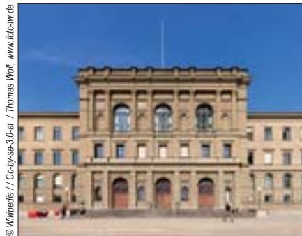
Hauptgebäude der ETH Zürich
