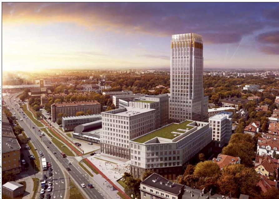
Visualisierung des Unity Centres in Krakau mit dem 102,5 m hohen Unity Tower
