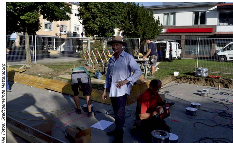
KR Michael Feyer besucht die Baustelle am Brunnenplatz
