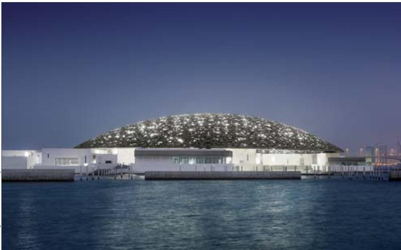
Mit 178 Metern Durchmesser entspricht die offene – aus Stahlprofilen gefertigte – Kuppelkonstruktion der Größe von fünf Fußballfeldern.
