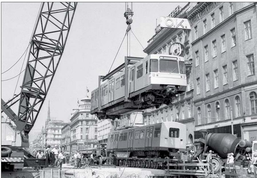
Mit einem Kran wird im August 1973 ein U-Bahn-Zug U-Bahn-schacht Kämtnerstrasse gehievt.
