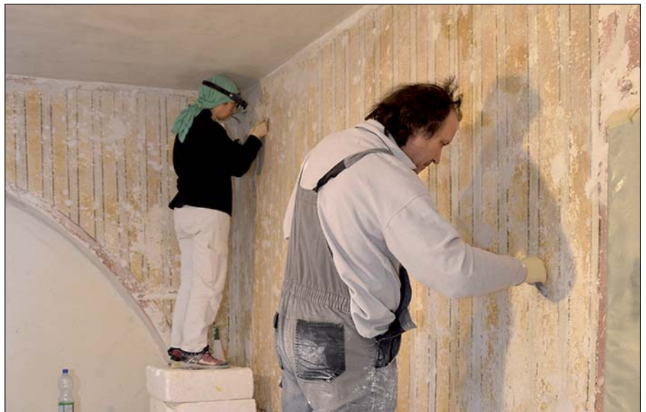
Bereits zum dritten Mal arbeiteten die RestauratorInnen an den originalen Wandmalereien
