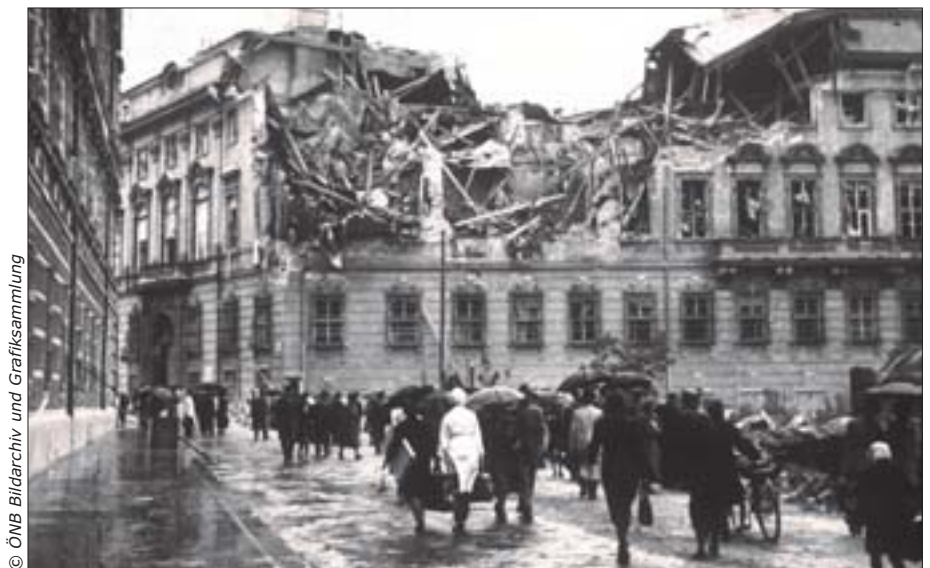
Bombenschäden des Zweiten Weltkriegs am Bundeskanzleramt, Foto: Albert Hilscher, 1945
