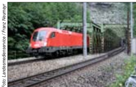
Bahnbrücke Pass Lueg / Salzburg
