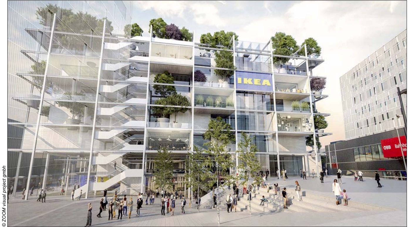
Ein Fassadenraster sorgt dafür, daß sich offene und geschlossene Elemente abwechseln und daß auf allen Ebenen Bäume wachsen können.
