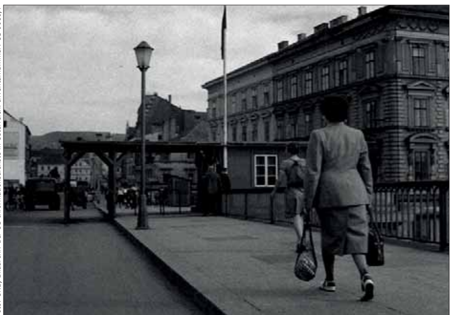
Der sowjetische Posten auf der rechten Seite des Brückenkopfes der Nibelungenbrücke in Linz/Urfahr. Das Foto entstand im Auftrag der United States Information Agency Pictorial Section der Information Services Branch (ISB)
