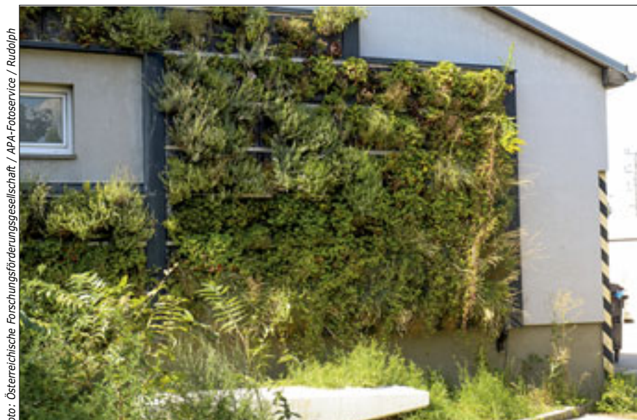
Die Verbesserung des Mikroklimas vor sowie im Gebäude hinter der Fassade ist durch die Begrünung sehr deutlich meßbar.
