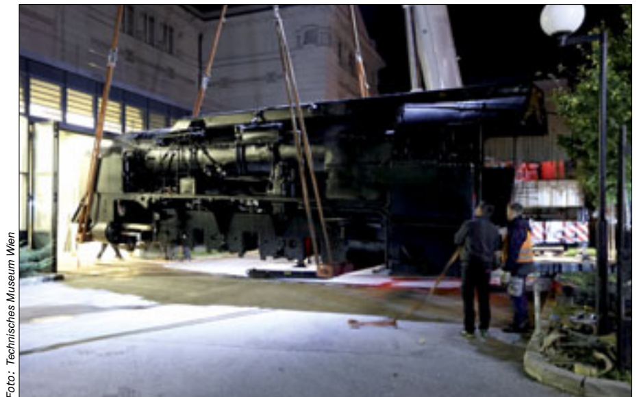
Die 80 Tonnen schwere Lokomotive wurde anschließend Millimeter um Millimeter abgesenkt...
