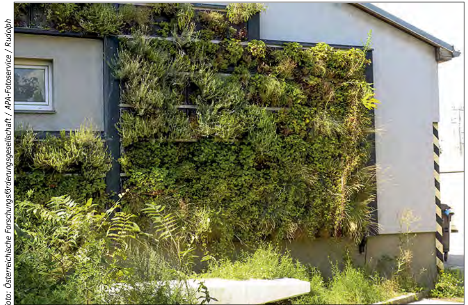
Die Verbesserung des Mikroklimas vor sowie im Gebäude hinter der Fassade ist durch die Begrünung sehr deutlich meßbar.
