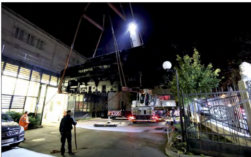
Die 12.10 wurde mit einem Kran über den Zaun beim Technischen Museum Wien gehoben.
