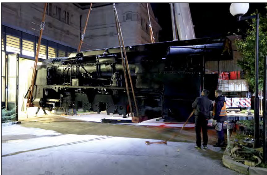
Die 80 Tonnen schwere Lokomotive wurde anschließend Millimeter um Millimeter abgesenkt...
