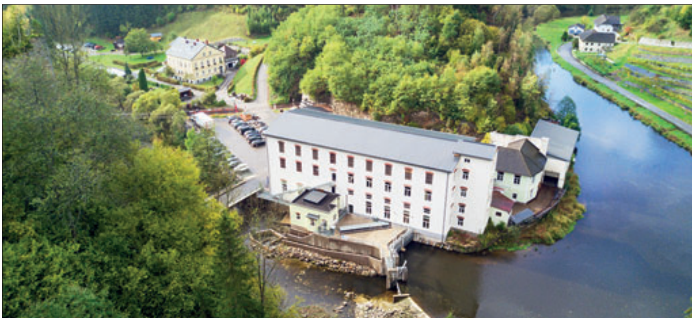
Foto: WWS Wasserkraft
