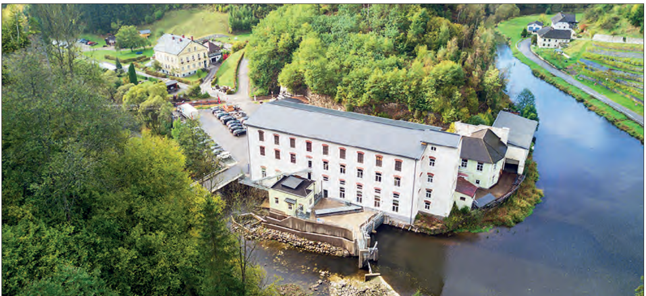
Foto: WWS Wasserkraft
