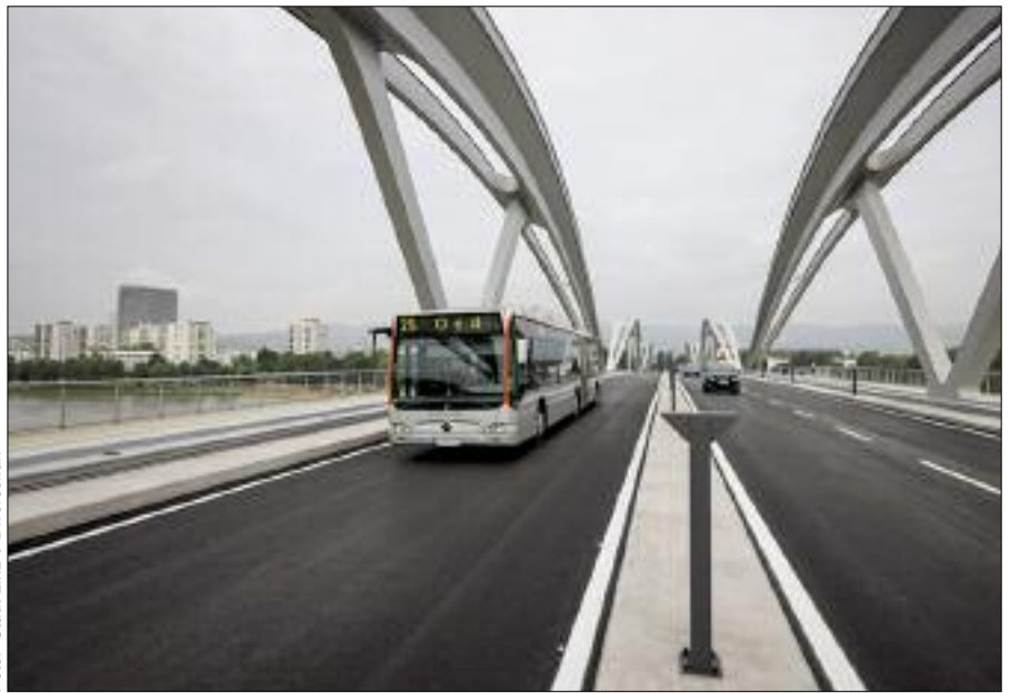
Die erste Fahrt über die Brücke war für den Autobus der Linie 25 reserviert...
