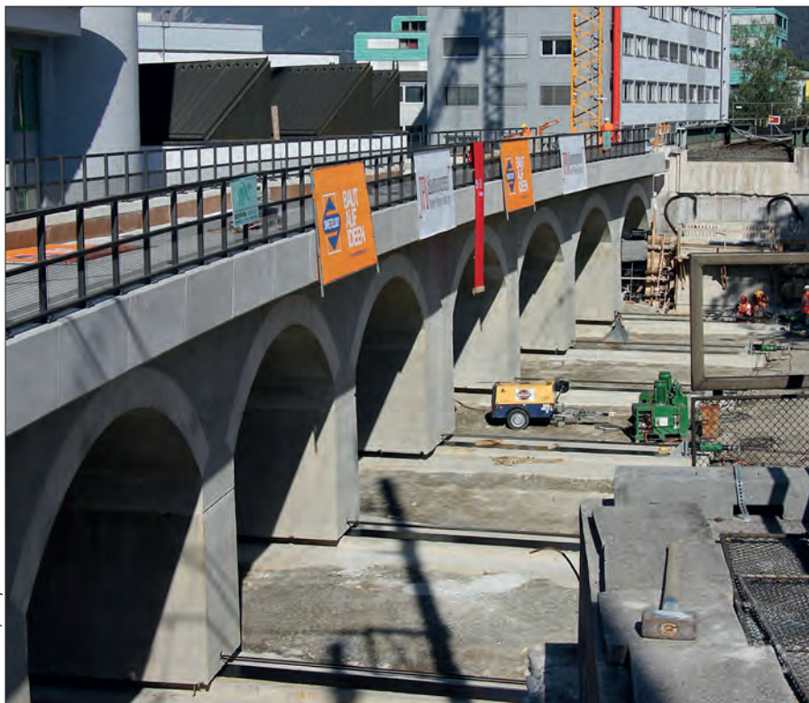
Einschub des ersten neuen Teilstücks des Inntalviaduktes. Im Vordergrund an den Pfeilern die Verschubbahnen.
