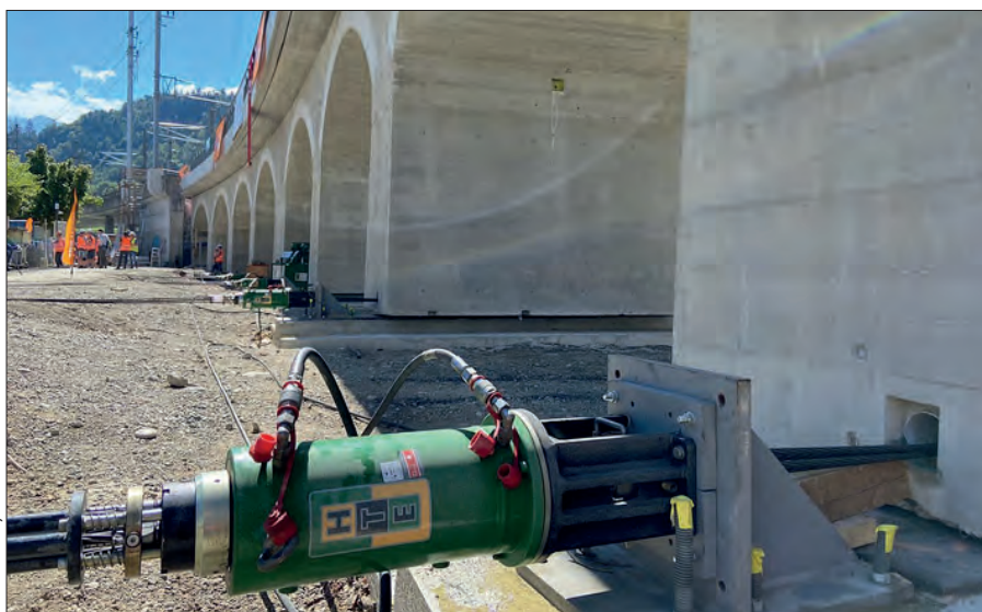
Die Herausforderung bestand darin, daß alle Pressen mit jeweils mit 400 bar Druck absolut gleichmäßig ziehen, damit es zu keinen Verschränkungen des Bauwerks kommt.
