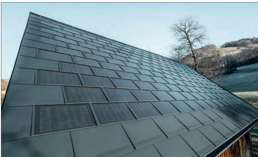
Durch die Integration der Photovoltaikmodule in der Dachplatte ist kein zusätzlicher Aufbau bzw. keine Unterkonstruktion auf dem Dach sowie keine Durchdringung der Dachhaut durch Schrauben, Leitungskanäle oder Ähnliches erforderlich.
