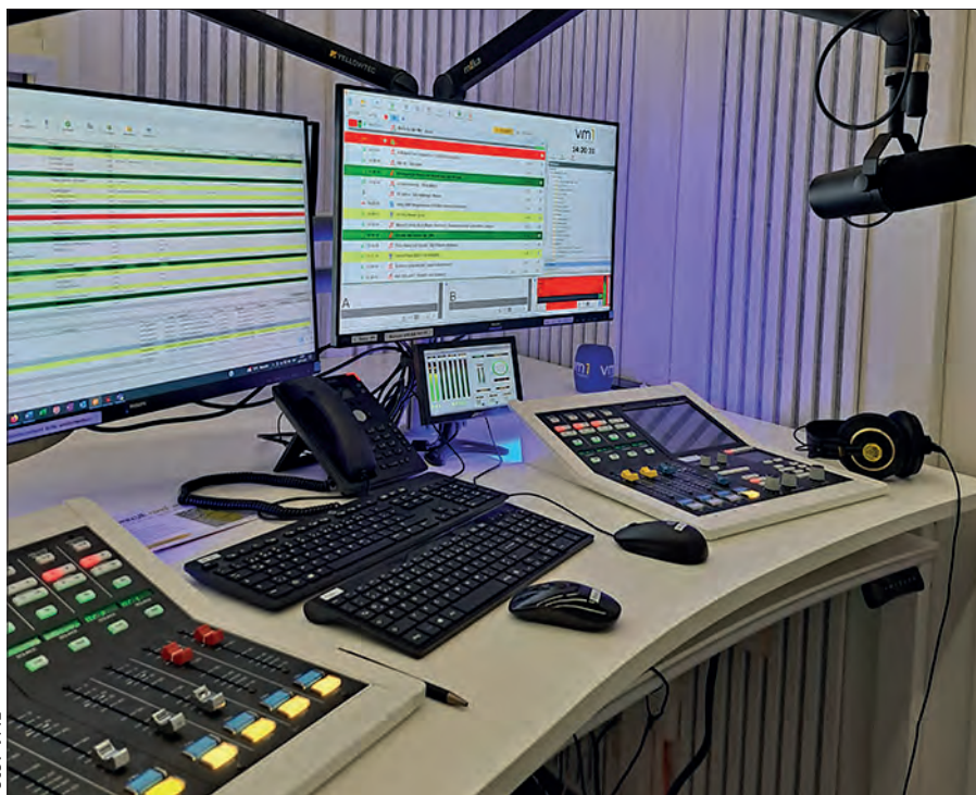
Hier entstehen die VM1 Sendungen: Ein Blick ins digitale Studio in Innsbruck Völs
