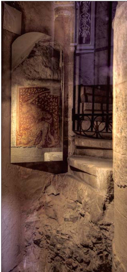
Am ersten Pfeiler des Langhauses der Stiftskirche wurde vor kurzem unter der barocken Ummantelung eine bemalte romanische Säule freigelegt.
